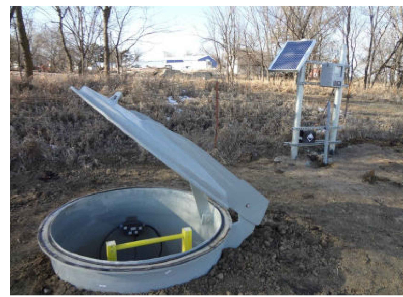
EXAMPLE MANHOLE ACCESS N.T.S
