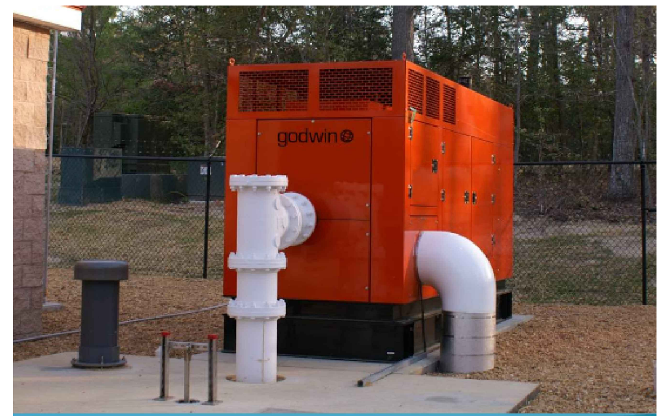
EXAMPLE DRY PRIME GENERATOR N.T.S
